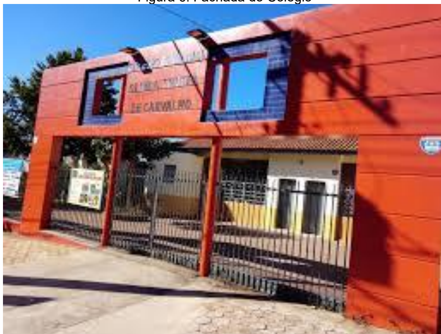
Figura 6: Fachada do Colégio
